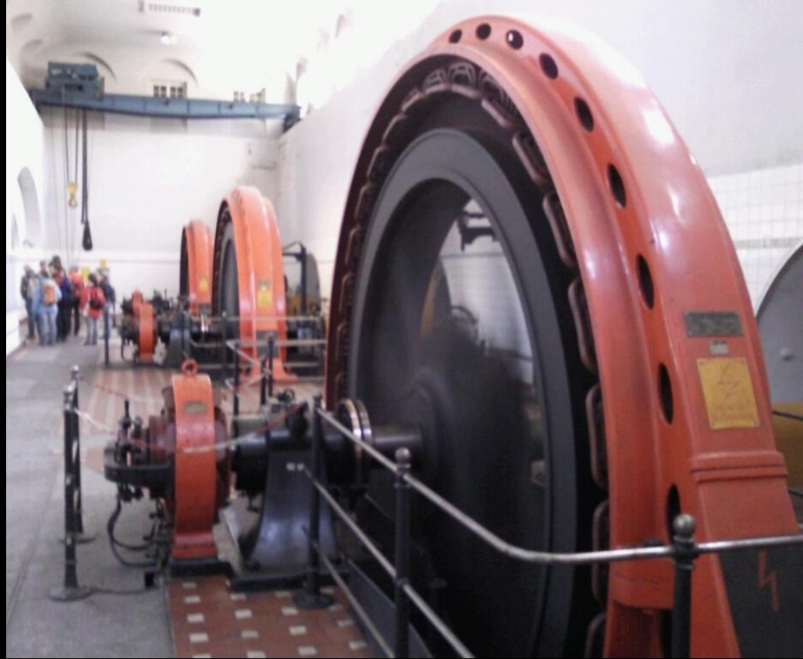
Wasserkraft in München Synchrongeneratoren im Isarwerk 1 Baujahr: 1908
